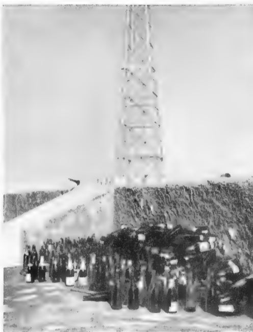
Un dépôt de bouteilles vides qui, cassées et incorporées au pisé, le renforceront.
